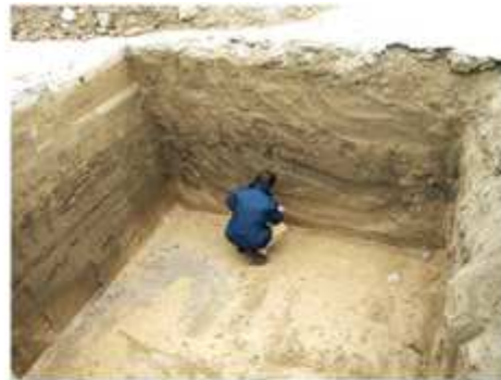
Ambiente confinato Fossa con possibile presenza di CO 2 , H 2 S, SO 2
