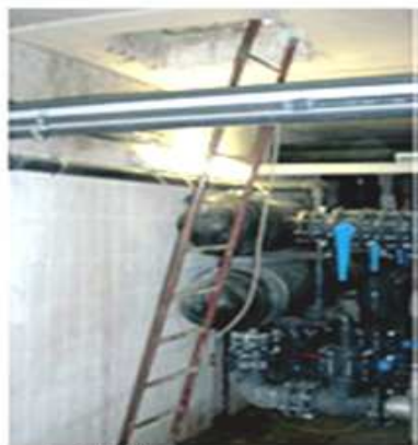
Ambiente assimilabile: locale tecnico piscine (INAIL fact sheet, 2020)
